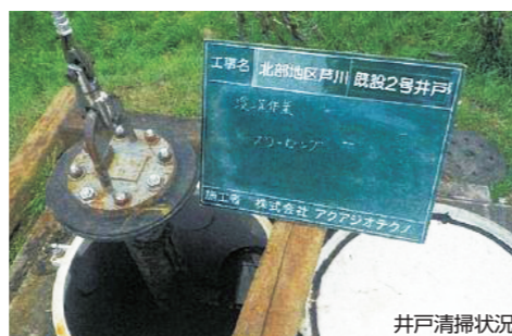
井戸清掃状況
