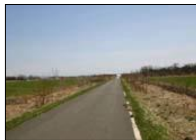
④ 農地と湿原の間に舗装道路がある区間
