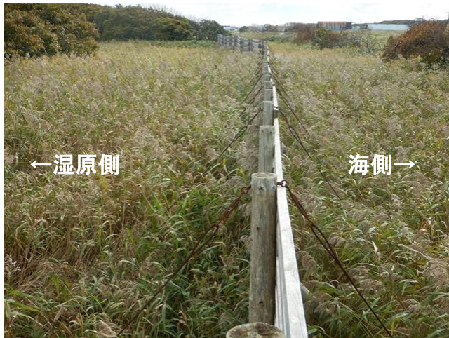
湖沼#112堆雪柵(H20設置)
