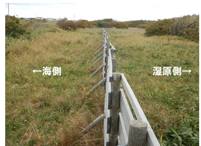
湖沼#112堆雪柵(H25設置)
