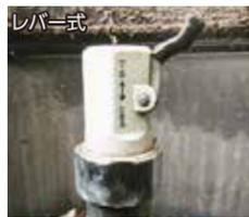
**レバー式水抜き栓 (縦レバー、横レバー)**
