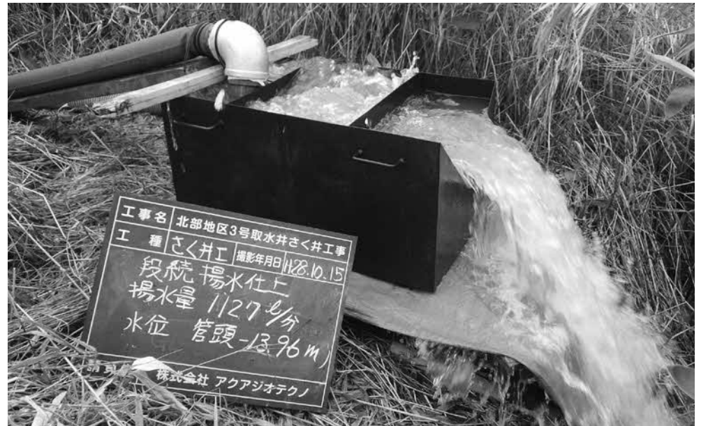
さく井工事の様子
