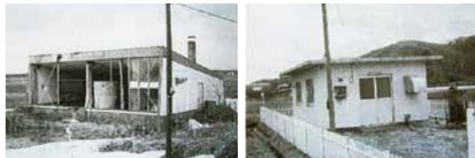
庄内地区の旧水道施設
