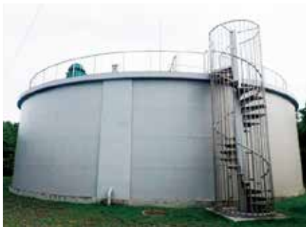
本町配水池(市街)
