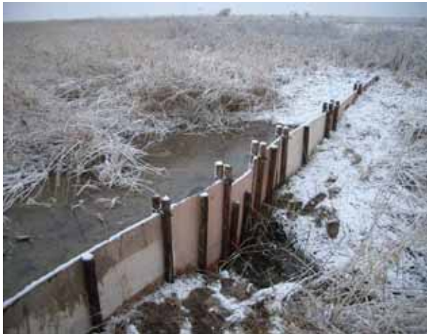
落合沼流出部 堰上げ翌朝の状況 (すでに堰天端近くまで湛水が見られる)
