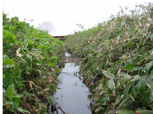
図 4-6 側溝(サロベツ川合流付近)
