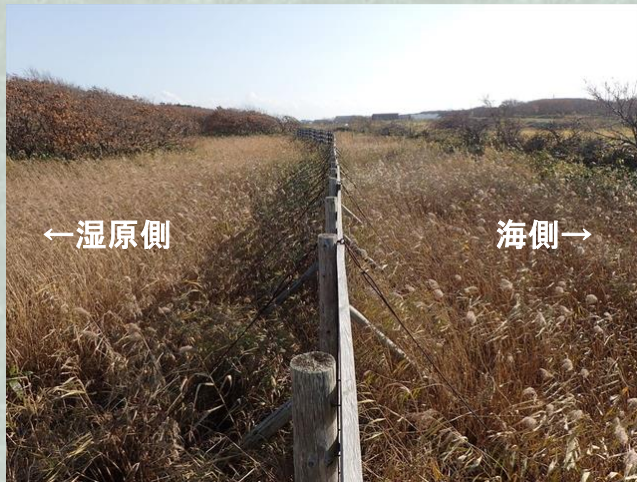
湖沼#112堆雪柵(H20設置)
