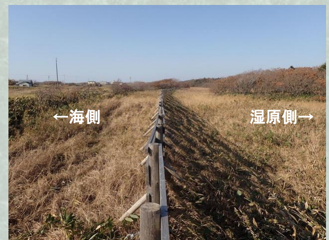
湖沼#112堆雪柵(H25設置)
