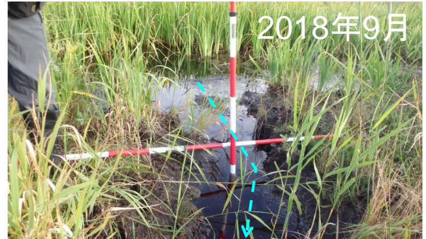
堰き止め工の一部で越流を確認 深さ30cm以上侵食されて流下
