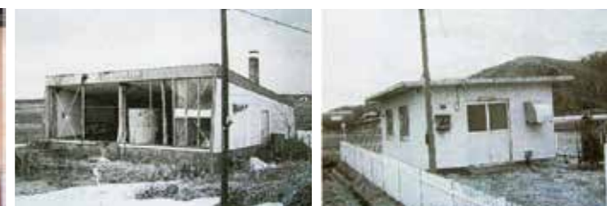
庄内地区の旧水道施設
