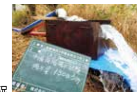
H29新設 芦川3号井戸揚水試験状況
